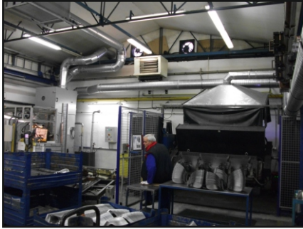
CIE UNITOOLS PRESS, Valašské Meziříčí - filtrační jednotka GM6V pro odsávání robotizovaného pracoviště pro MAG svařování a čtyř pracovišť pro odporové svařování....
