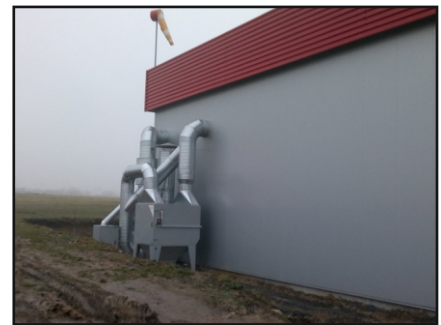
Strojárna Litvínov - filtrační jednotka GM9V pro centrální celoplošné odsávání haly systémem TCL.
