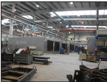
TDS Zampra, Frýdlant nad Ostravicí - 4x filtrační jednotka GM pro celoplošné centrální odsávání svařovny, a dále 13-ti brousících stolů a obrobny.
