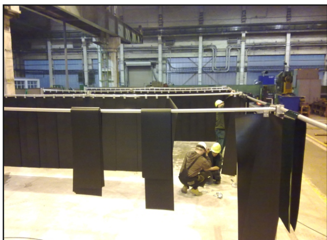
DT - Výhybkárna a strojírna, Prostějov - zde na fotografii probíhá montáž nových svařovacích boxů. Stěny boxů jsou tvořeny lamelami tmavosti T75M.
