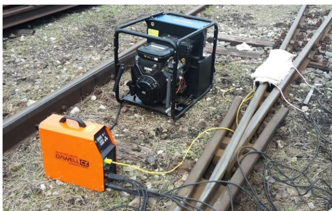
Předehřev kolejnic při jejich opravách - napájení elektrocentrálou.
