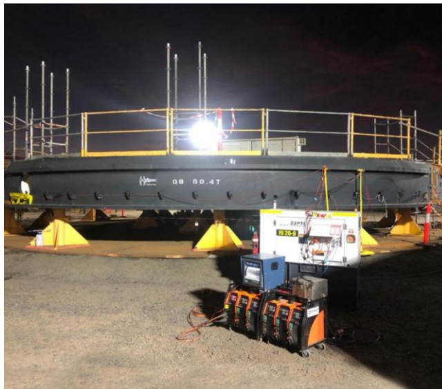
Předehřev důlního rypadla je provedeno 6-ti zdroji DAWELL, které byly řízené jedním programem...
